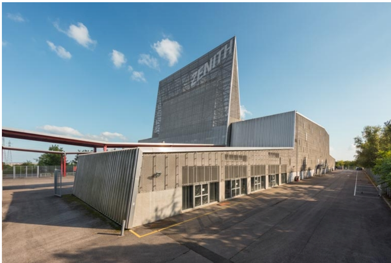
Façade latérale droite, de trois quarts gauche.
