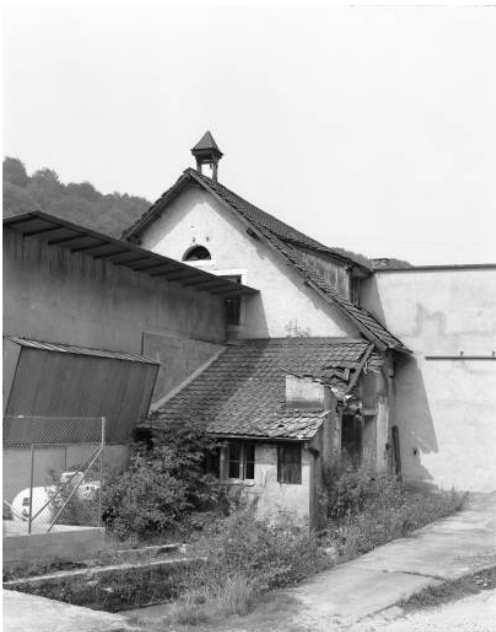
Pignon d'un atelier de fabrication en 1981.
