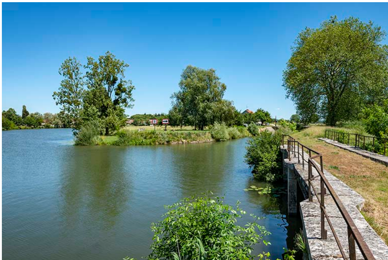
Sortie aval de la dérivation.
