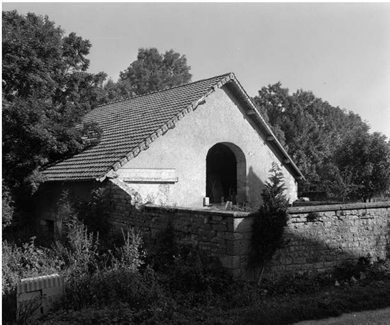
Façade antérieure des parties agricoles.
