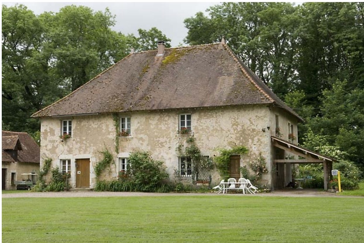
Logement patronal vu de trois quarts droite.
