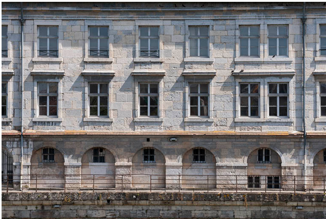
Façade postérieure : partie gauche et travée centrale (marquée par les fenêtres doubles).
