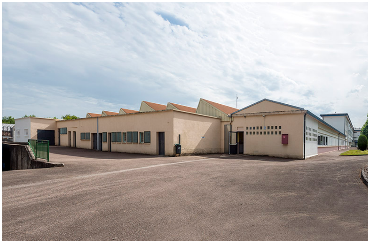
Ateliers : façade latérale.
