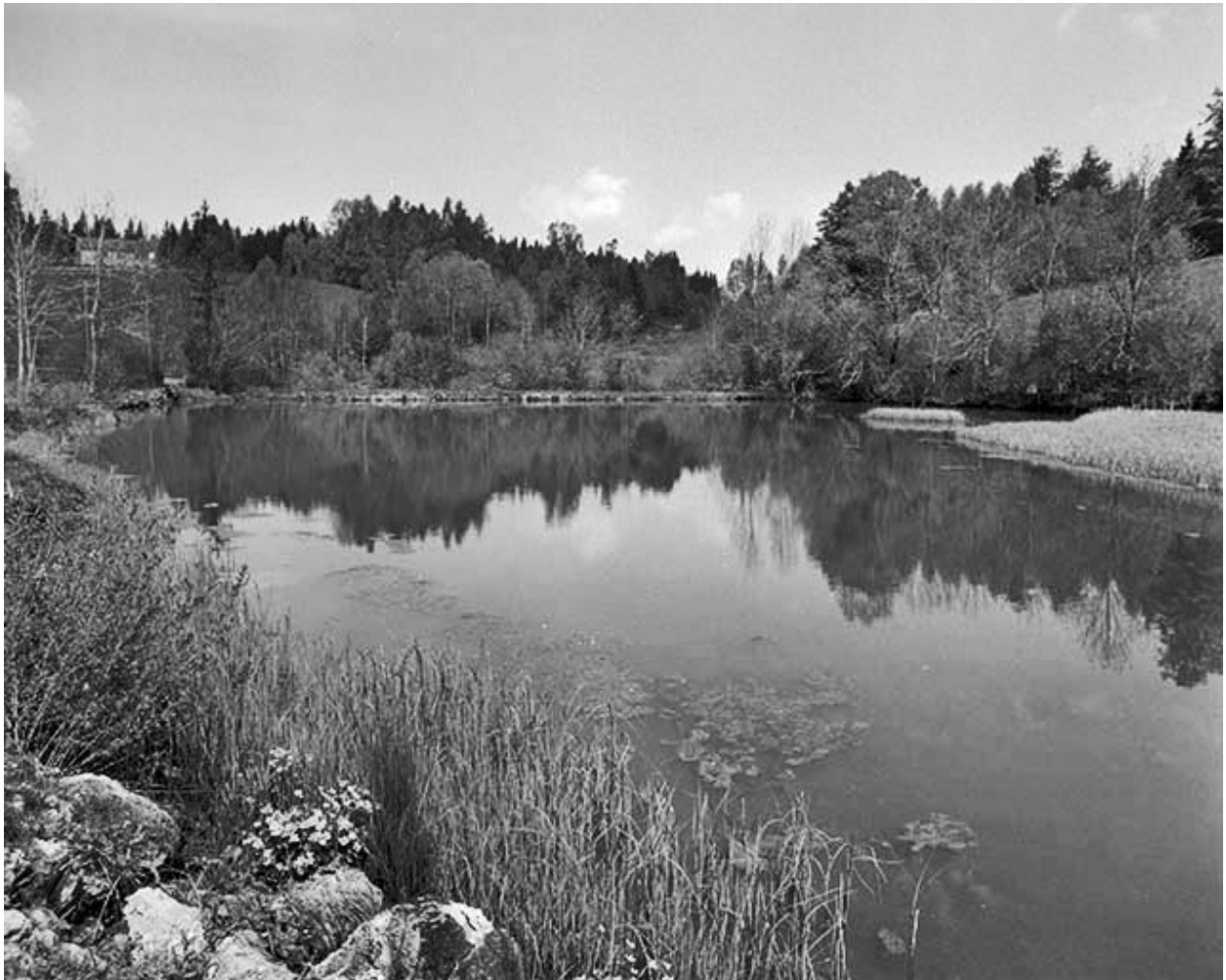
Bassin de retenue d'eau.
