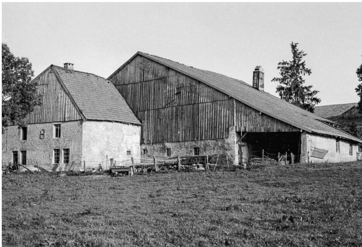
Ferme : façade antérieure.
