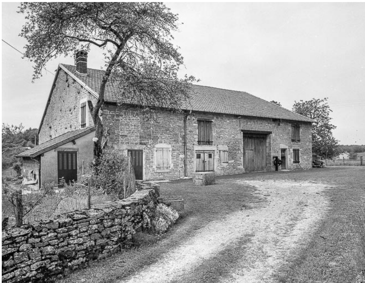
Ferme : façade antérieure.
