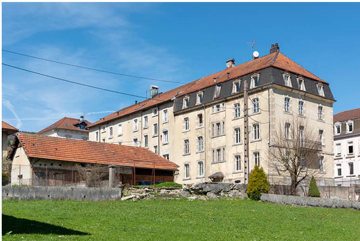
Façades postérieure et latérale gauche.
