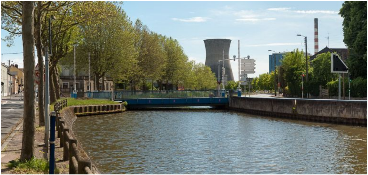
Vue d'ensemble du pont basculant de Montceau-les-Mines.
