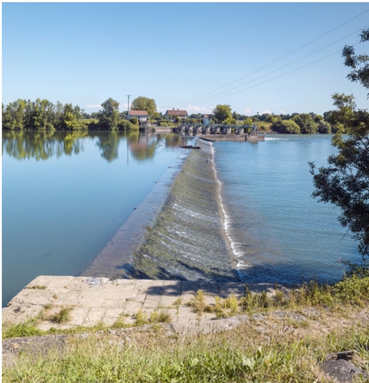
Le déversoir du barrage.
