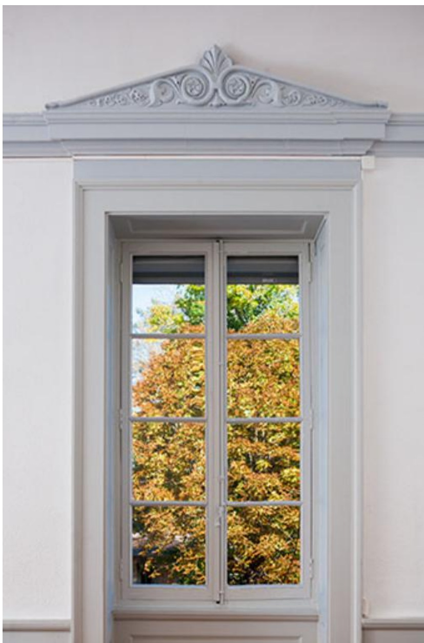
Détail de l'une des baies
