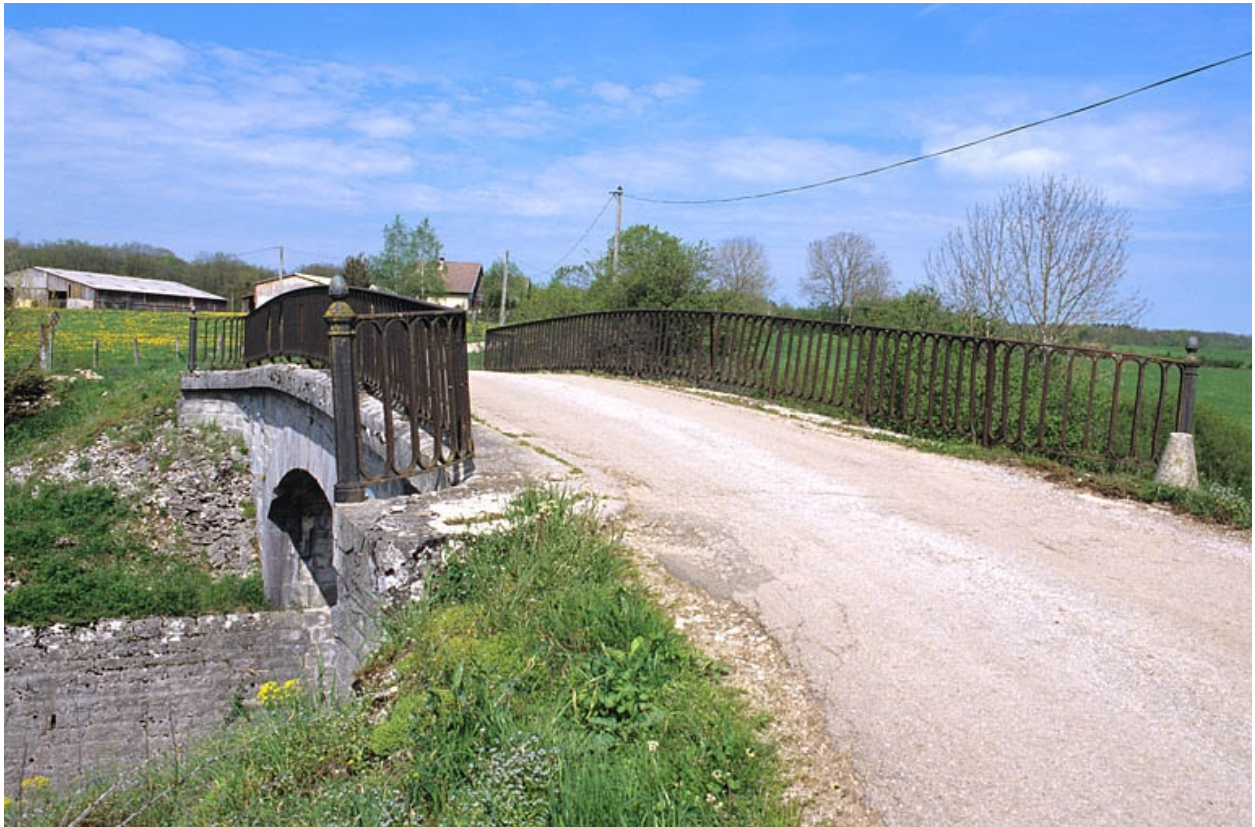
Tablier et garde-corps, depuis le nord-ouest.
