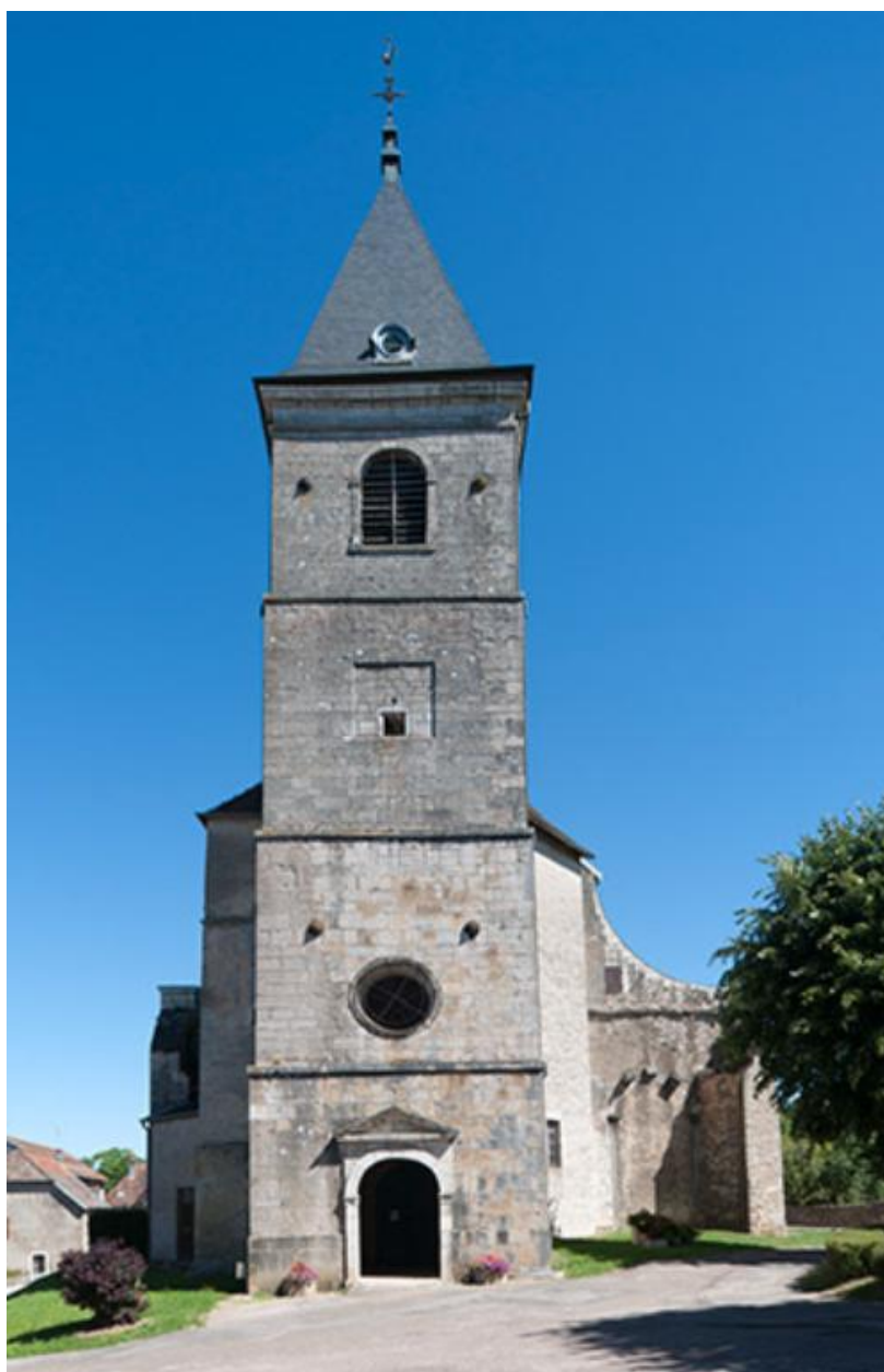
Façade ouest de l'église
