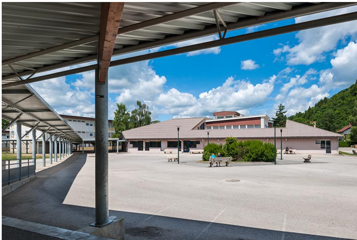
Restauration : vue d'ensemble, extension et bâtiment initial.
