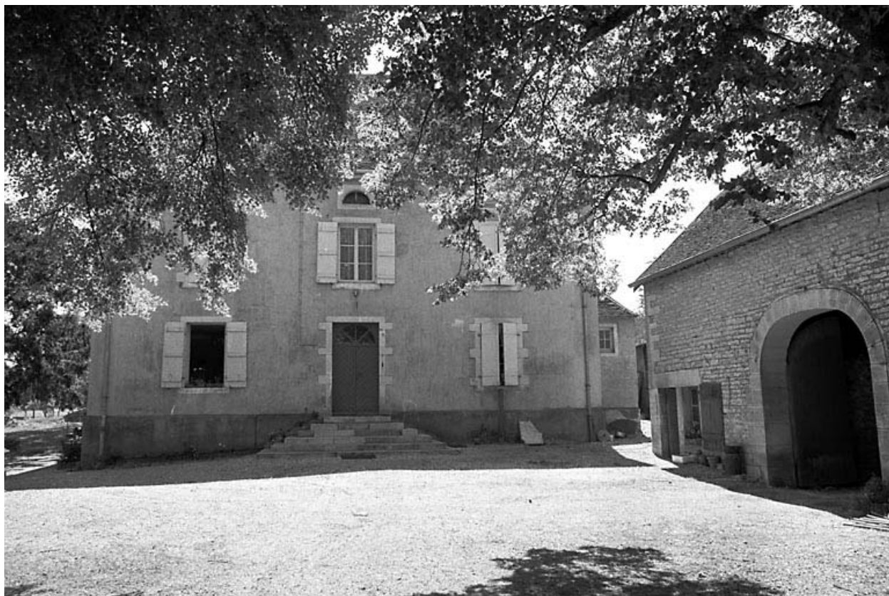
Vue des bâtiments depuis la cour.
