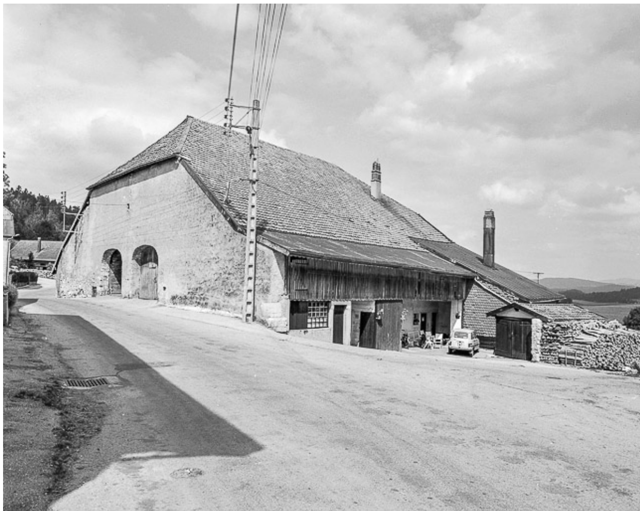
Pignon sur rue et goutterot.
