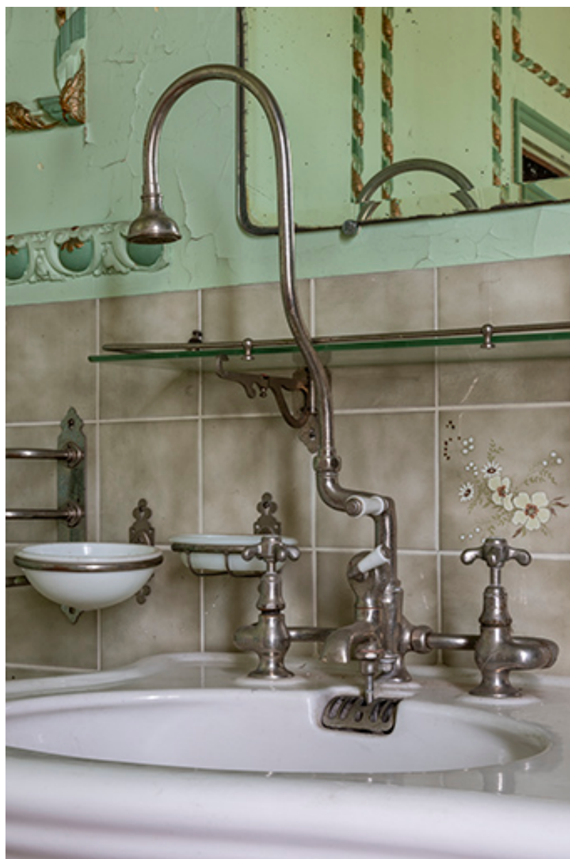
Premier étage, salle d'eau, robinets.
