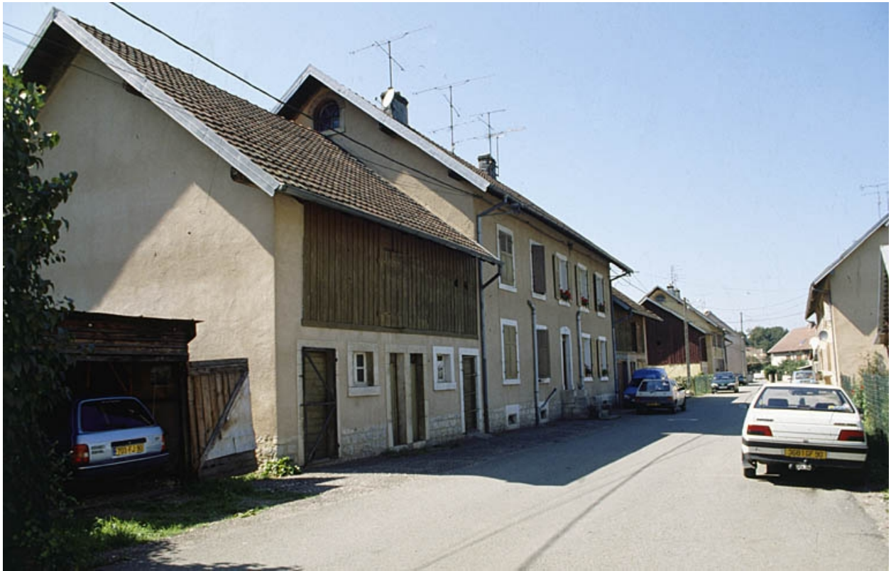
Logements ouvriers collectifs avec dépendances.
