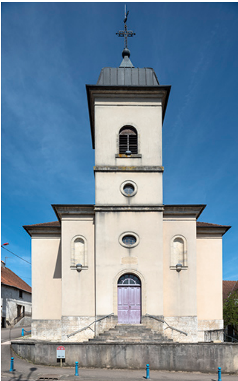
La façade antérieure de la chapelle.
