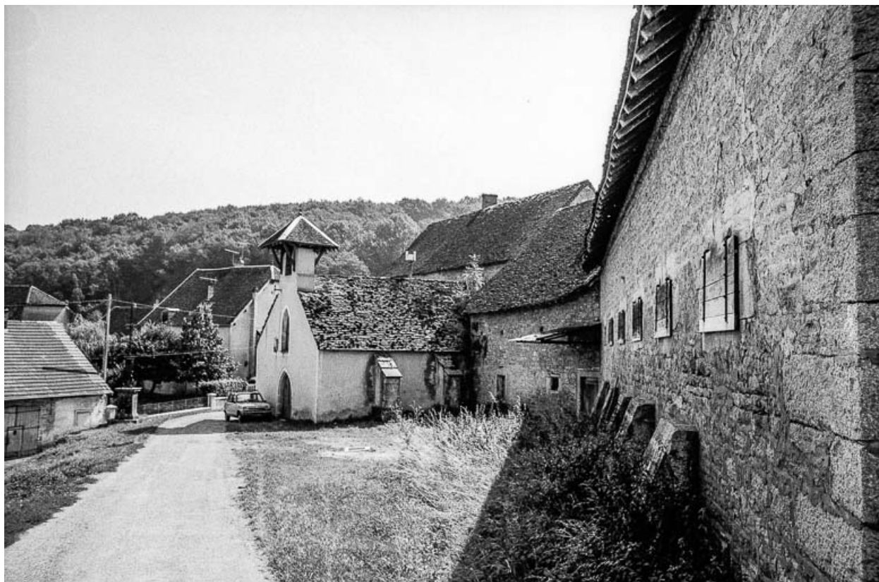
Chapelle et partie agricole : façades sur rue.
