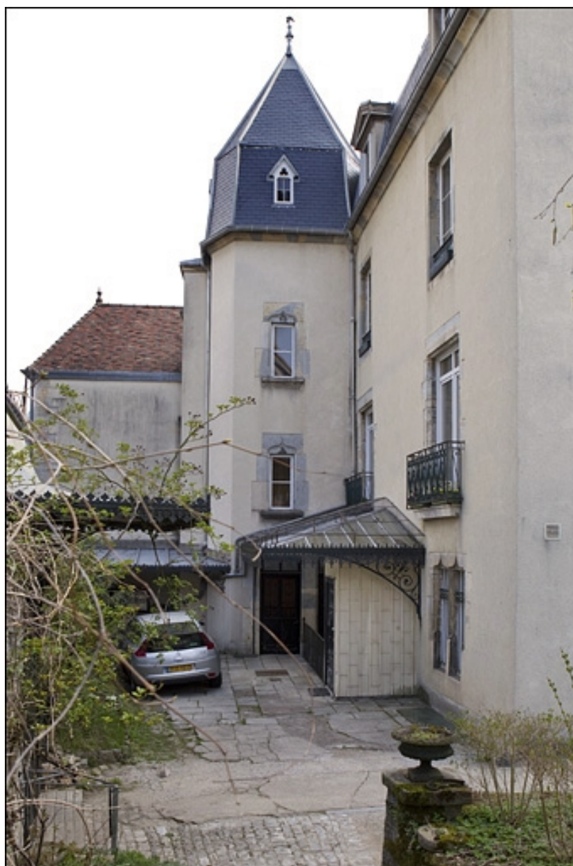
Logis principal : détail de la tour d'escalier.
