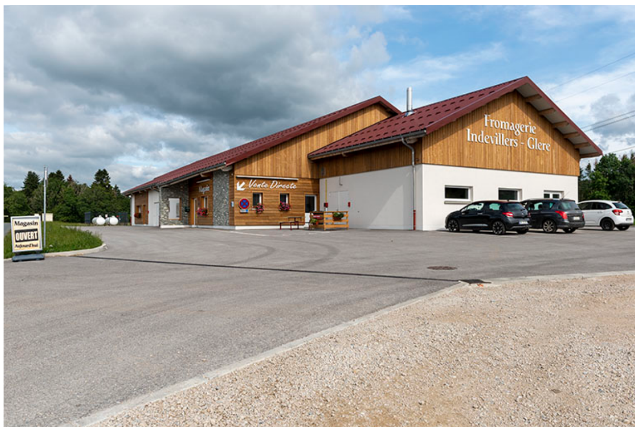
Façades antérieure et latérale droite.
