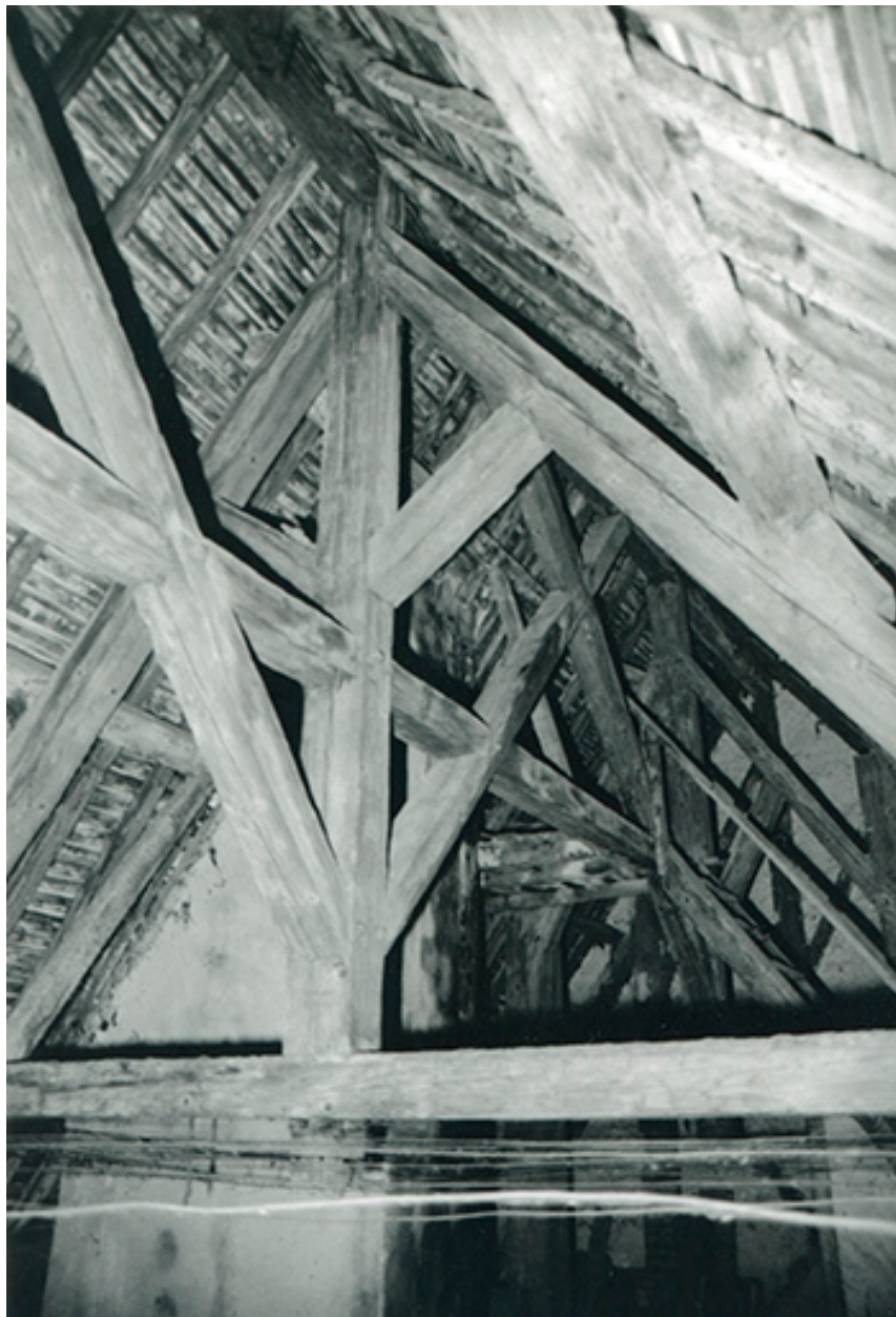
Charpente du bâtiment conventuel, 1997.
