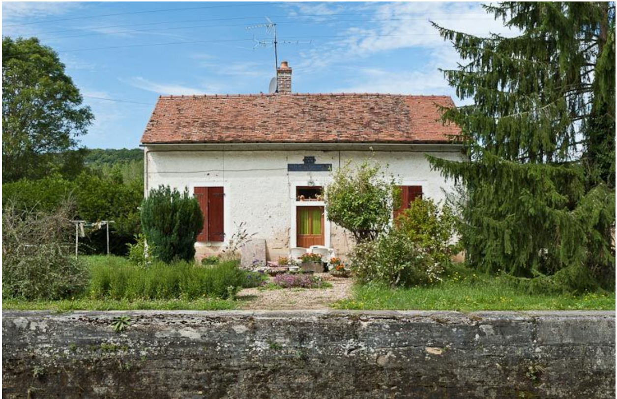
Vue de face de la maison éclusière.
