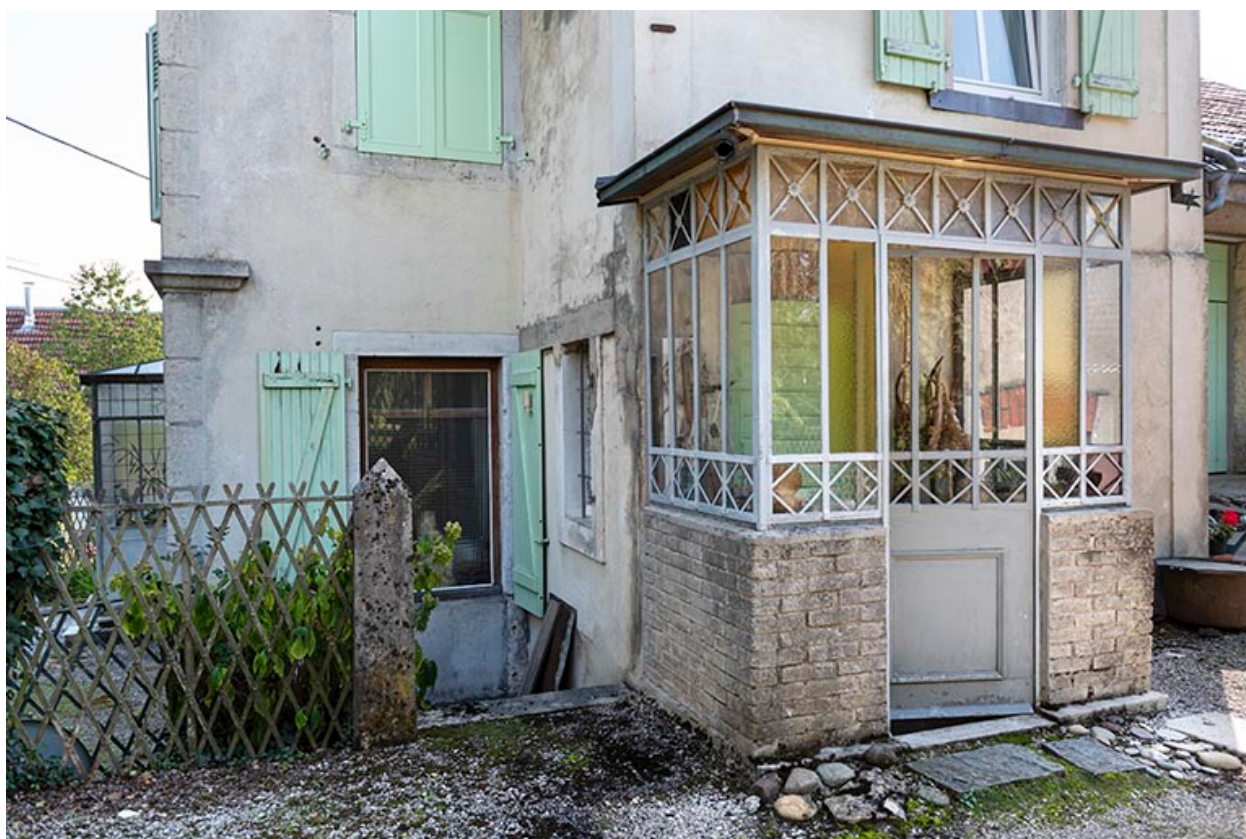
Logement Hugoniot : véranda nord, de trois quarts.
