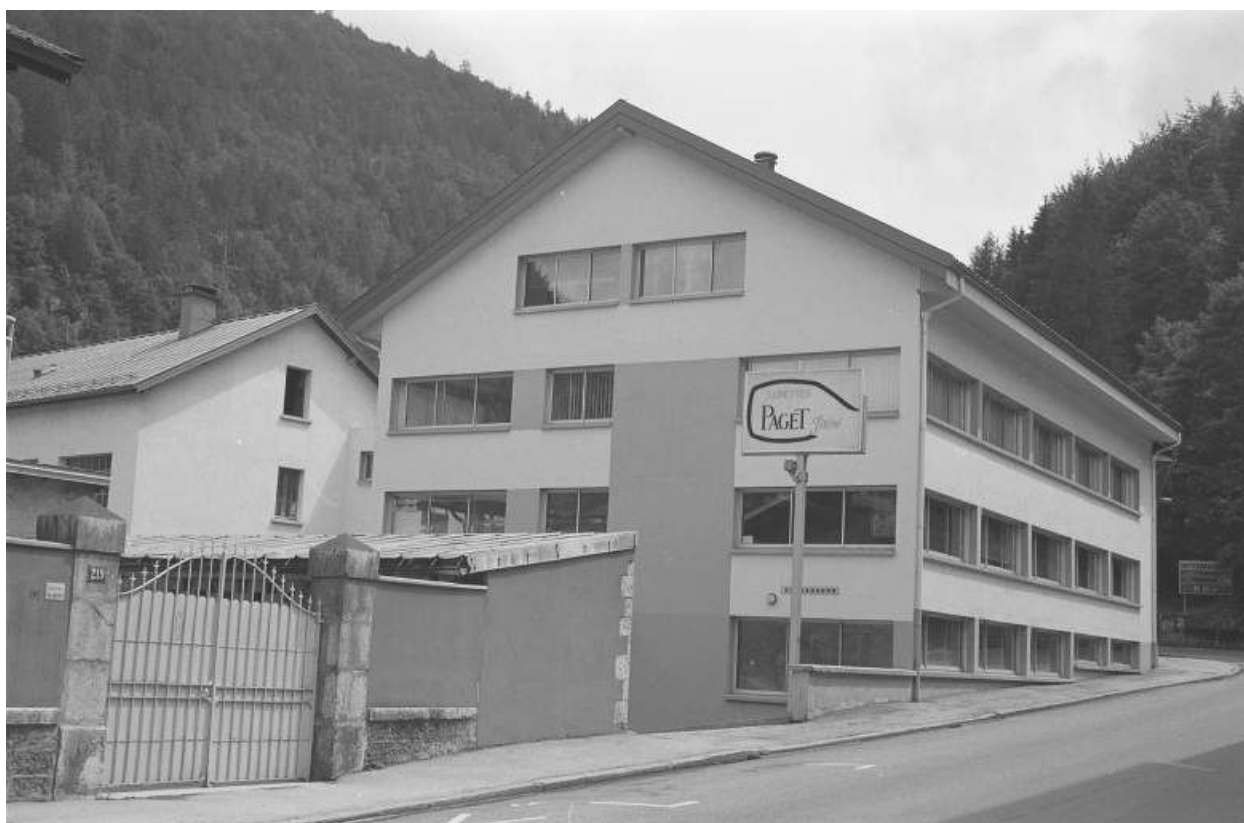
Façades postérieure et latérale droite des bureaux.
