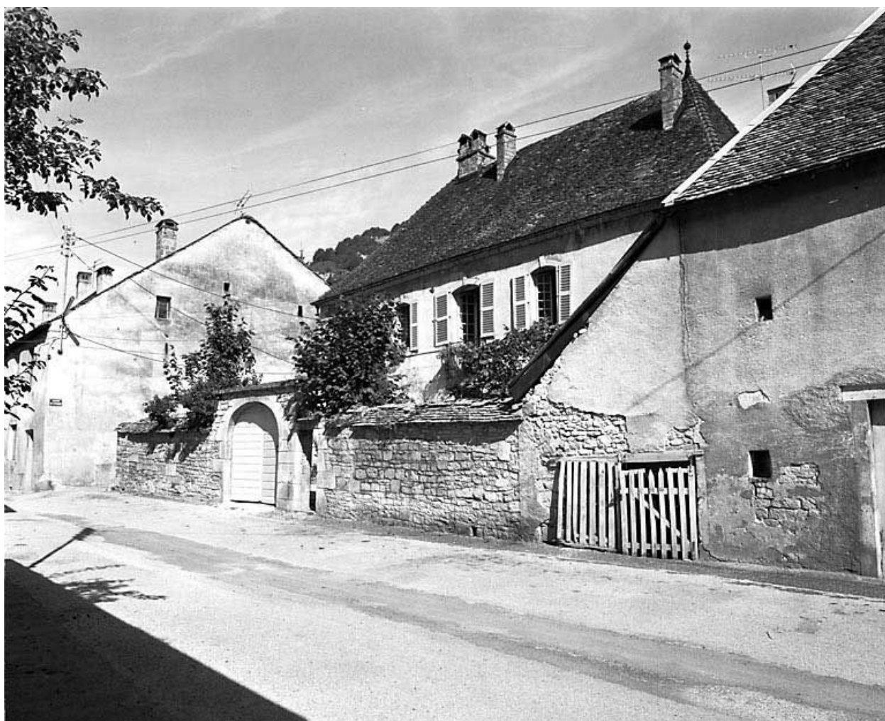
Maison de vigneron située à Vuillafans.
