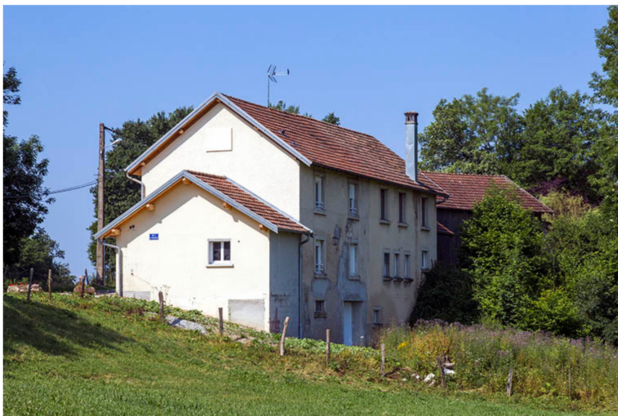
Façades postérieure et latérale droite.
