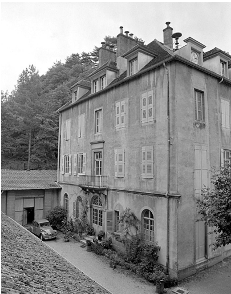
Façade antérieure du bâtiment C.
