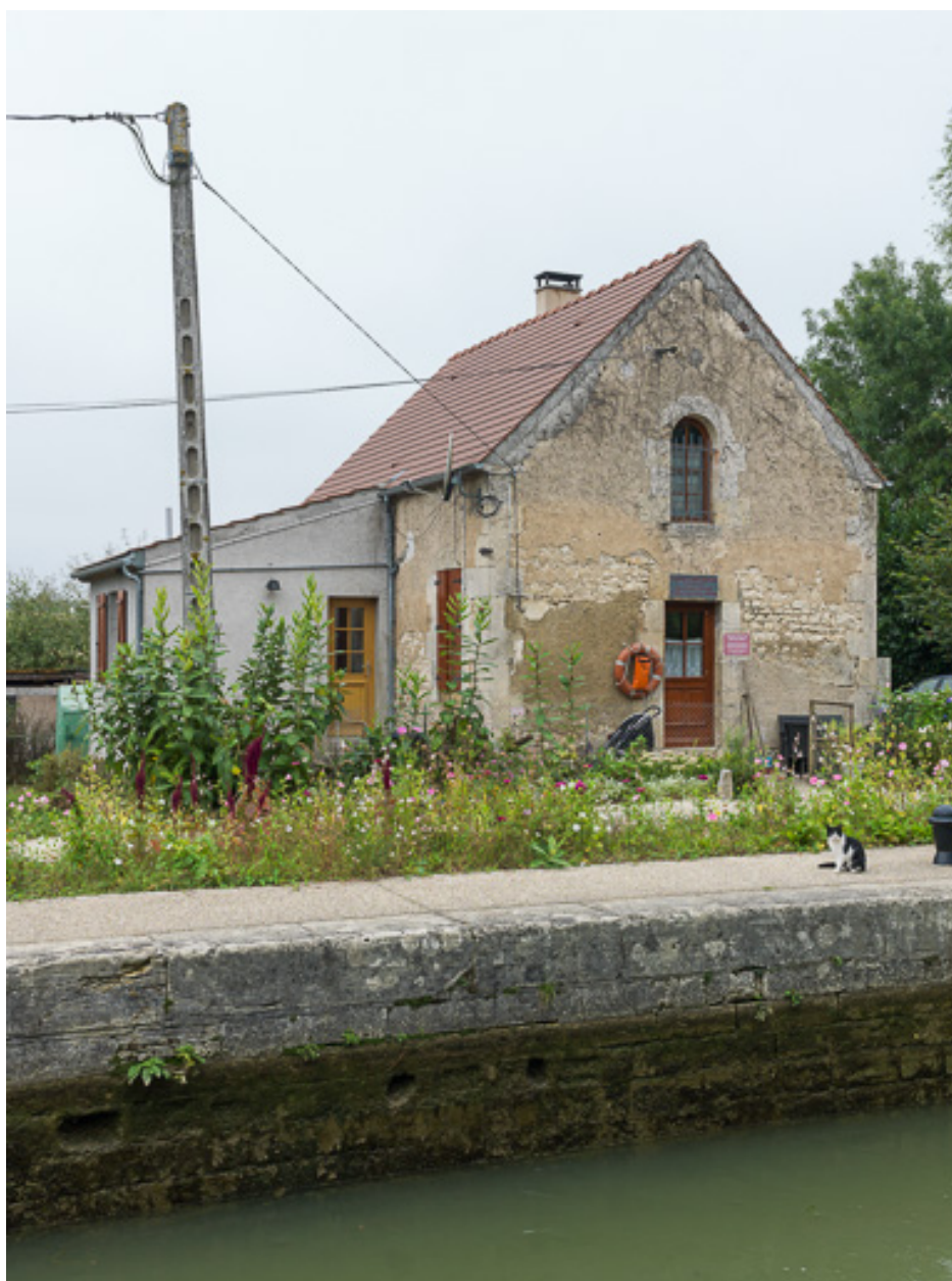
Vue de la maison éclusière.
