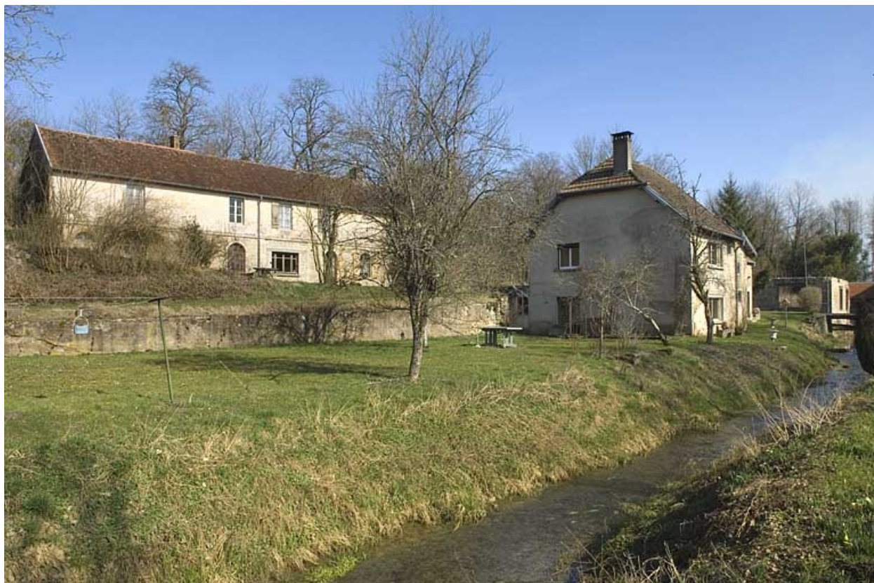
Vue d'ensemble des logements depuis le sud-ouest.
