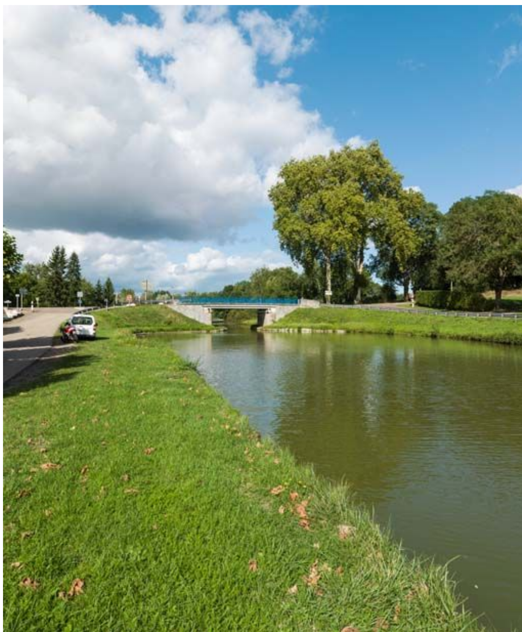
Vue d'ensemble du pont.
