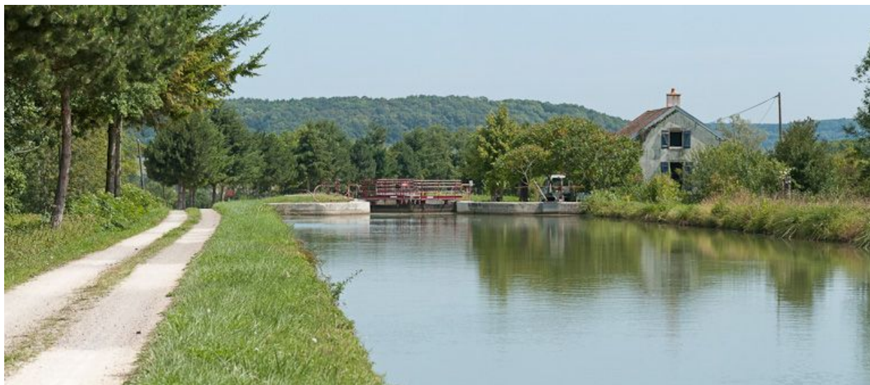
Vue du site d'écluse en amont.
