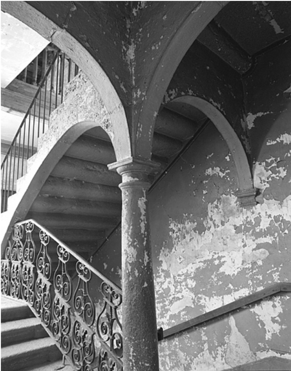
Escalier vu depuis le premier palier.
