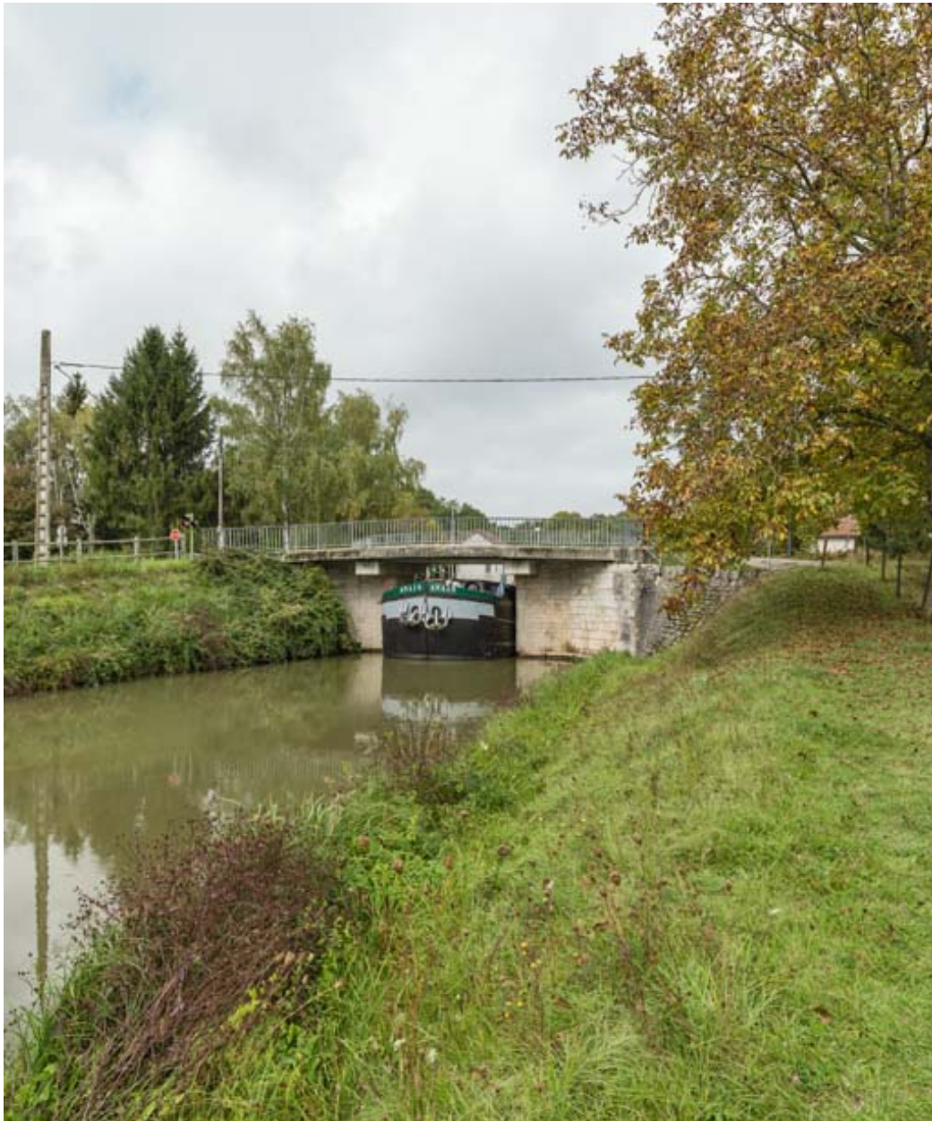
Vue d'ensemble du pont.
