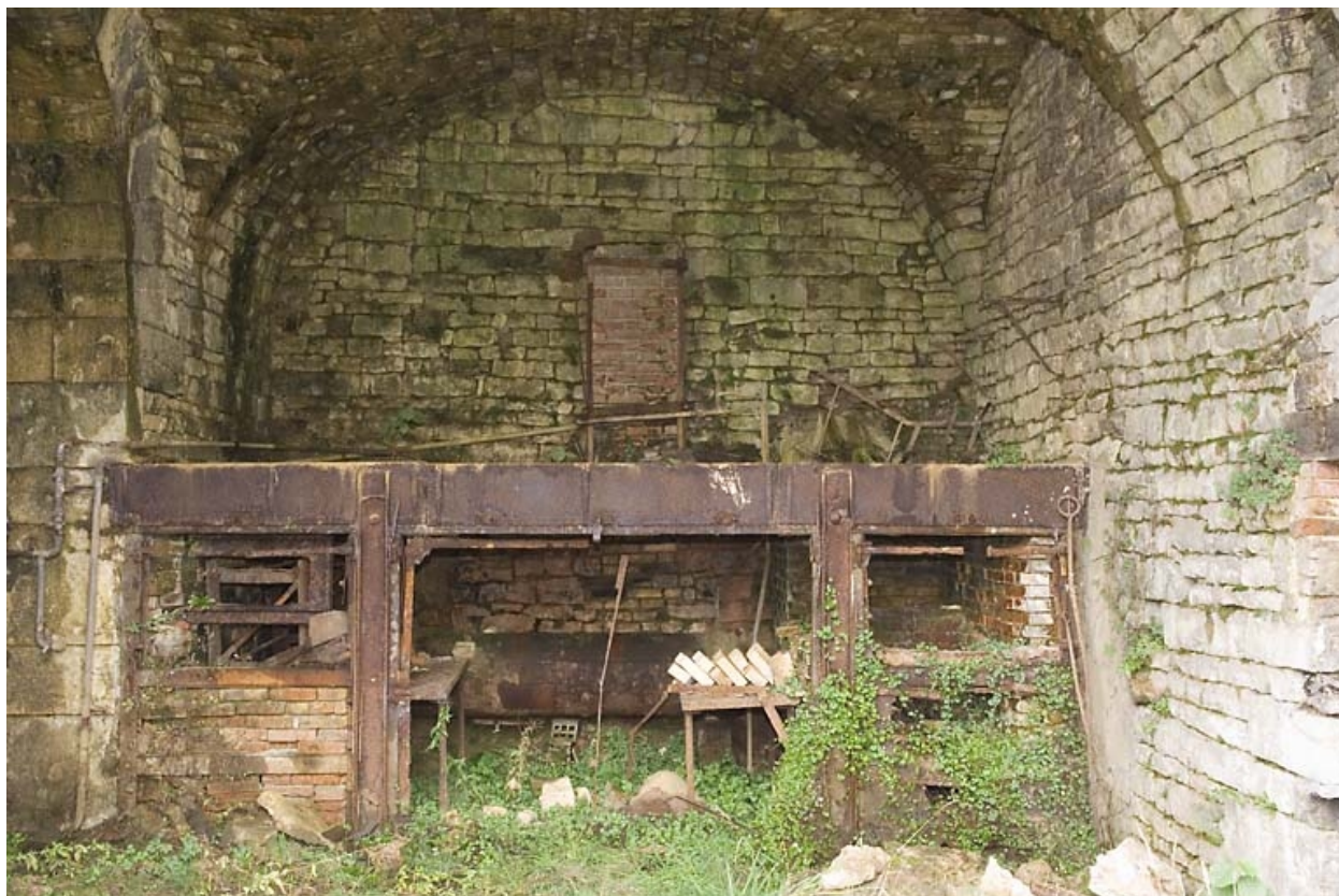
Salle des cubilots. Vestiges d'un four (?).
