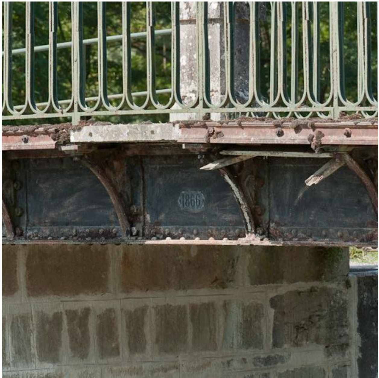
Détail du pont sur écluse.
