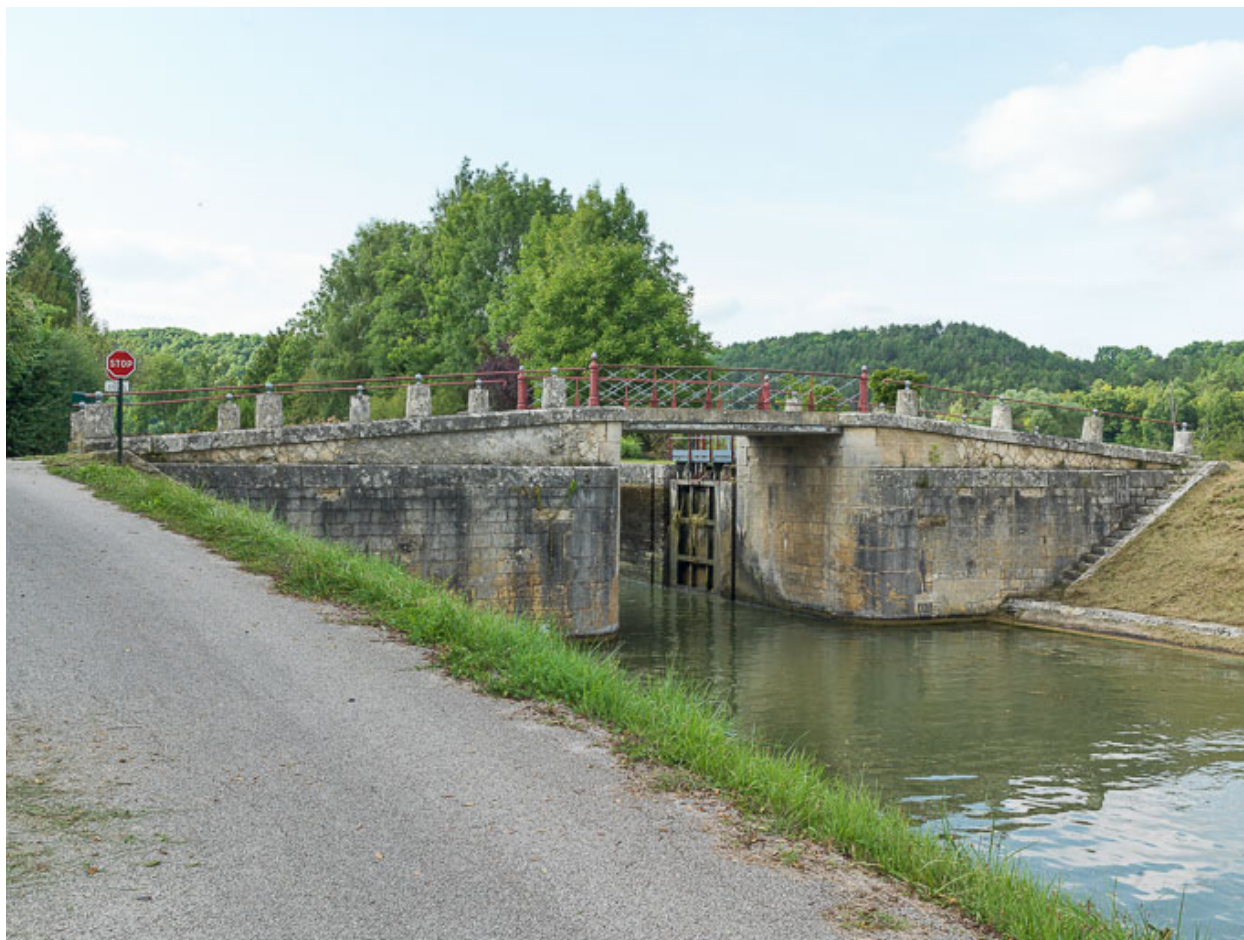
Vue d'ensemble du pont.
