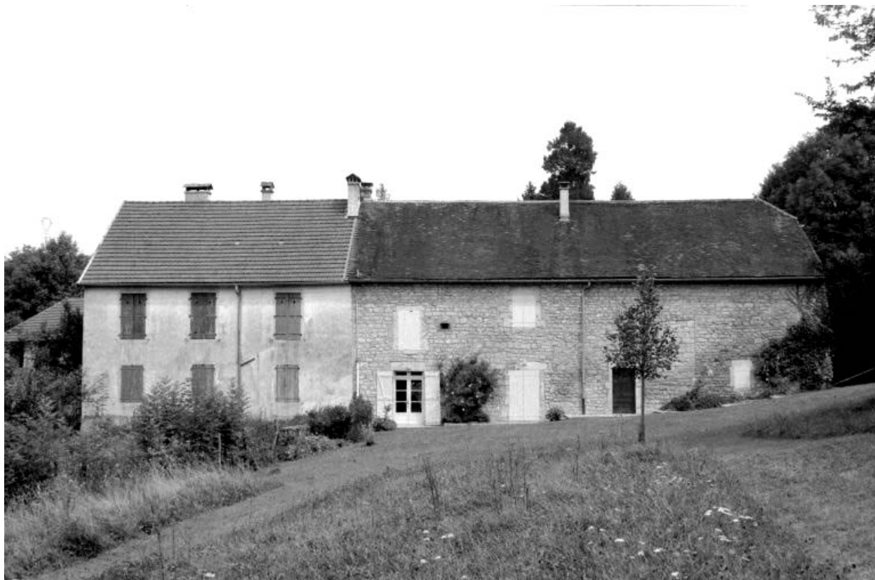
Façade antérieure du logement et de l'étable.
