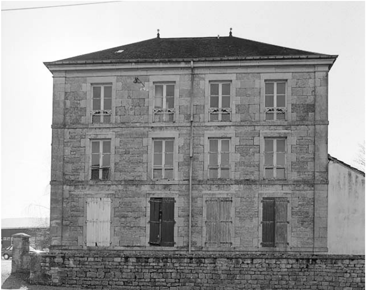
Façade antérieure du logement d'ouvriers.
