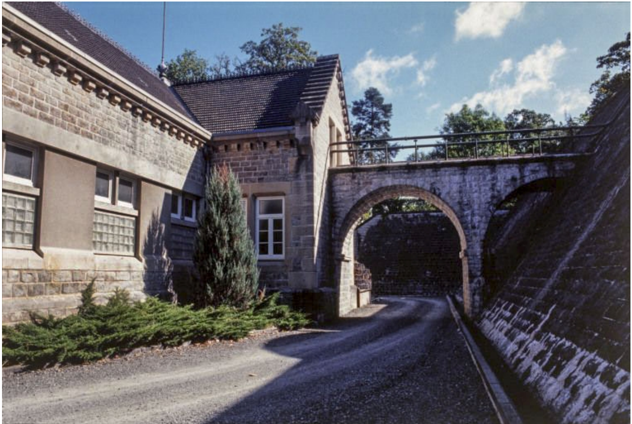
Élévation postérieure et pont-aqueduc.
