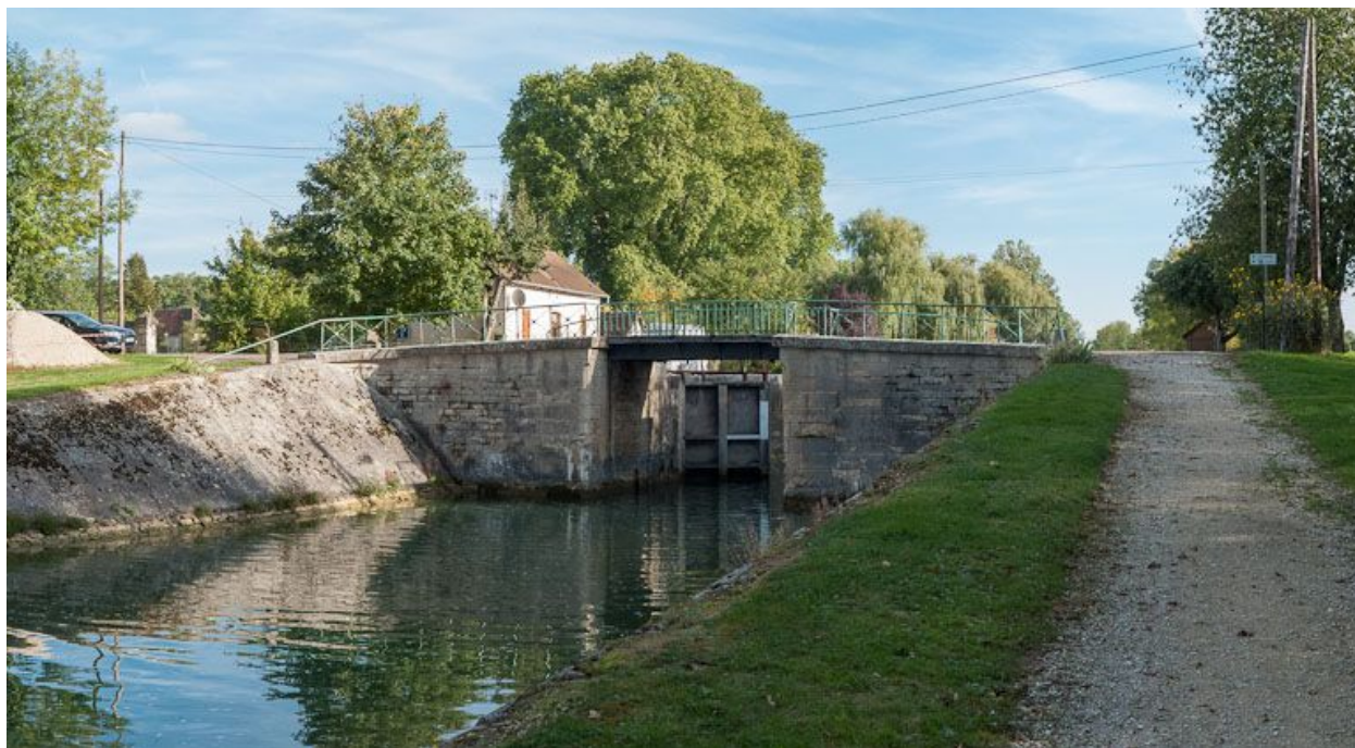
Vue d'ensemble du site, prise d'aval.
