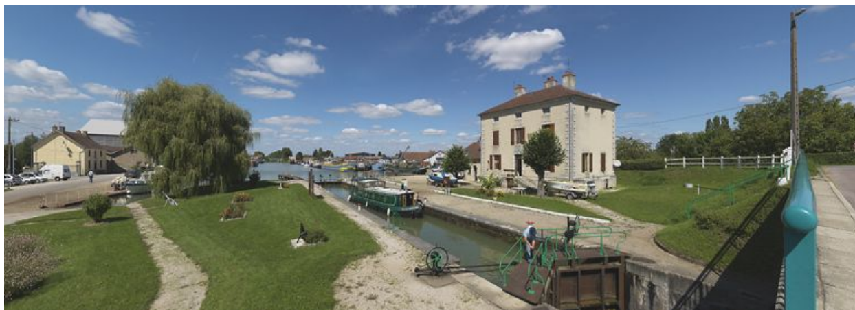
Ensemble du site vu d'aval.
