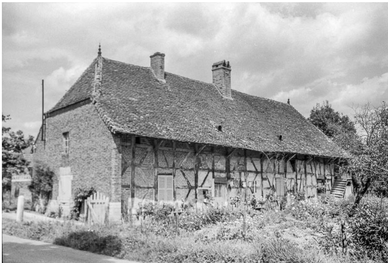
Ferme : vue générale.
