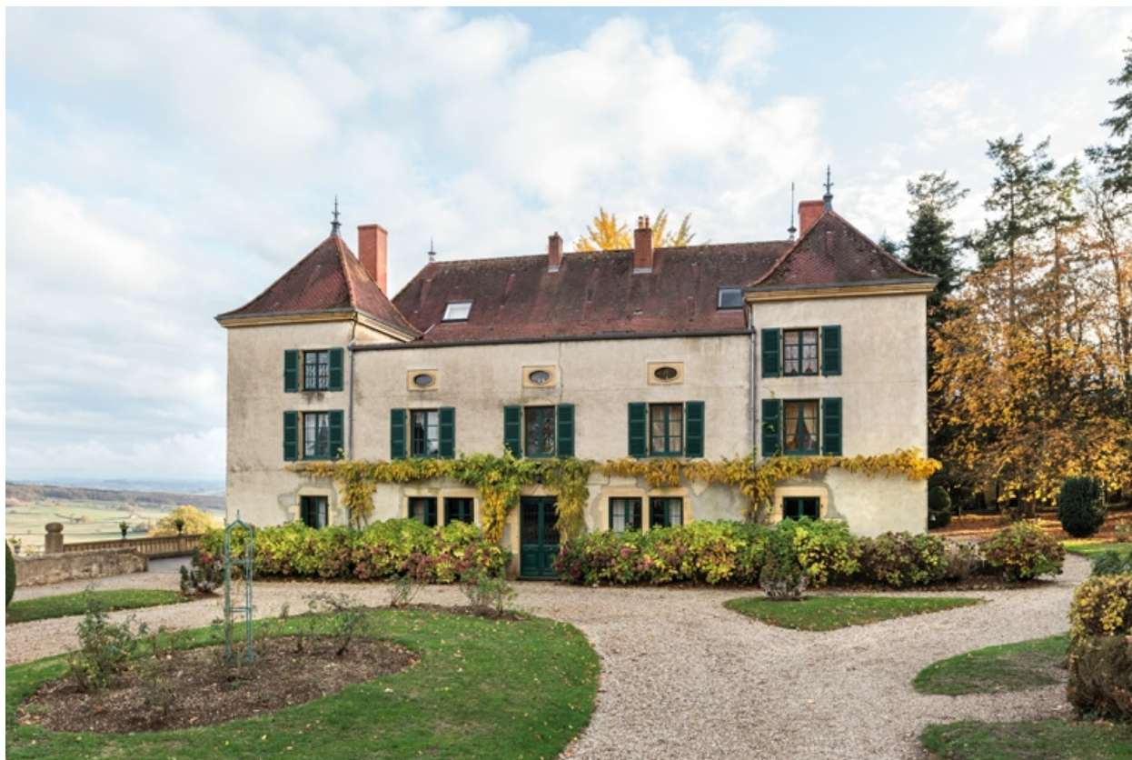
Façade antérieure du château
