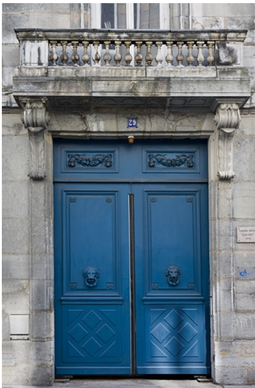
Détail du portail d'entrée sur rue.
