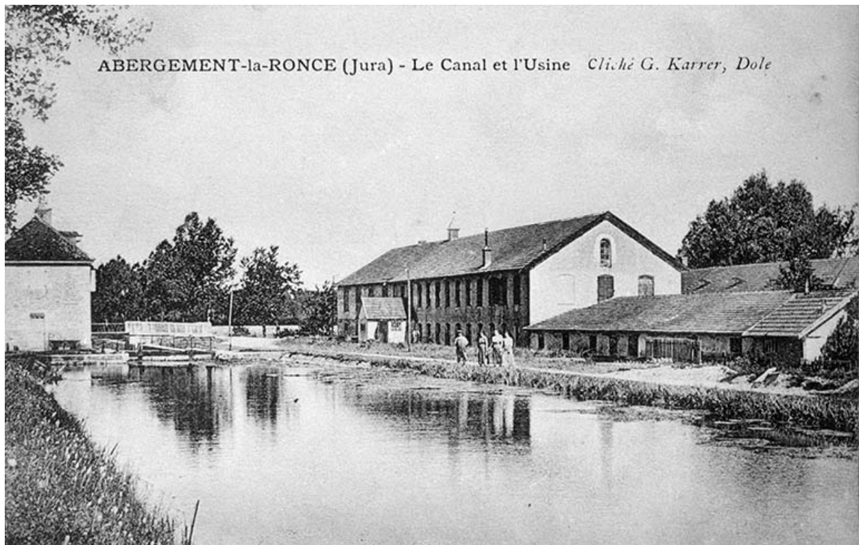
Abergement-la-Ronce (Jura) - Le Canal et l'Usine.
